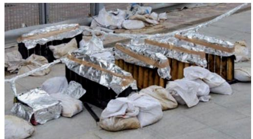
Imagen 18. Detalle de los efectos aéreos (carcasas), protegida de la intemperie mediante papel aluminizado. Nótese el lastrado mediante sacos areneros y la protección de la línea de conexión.
