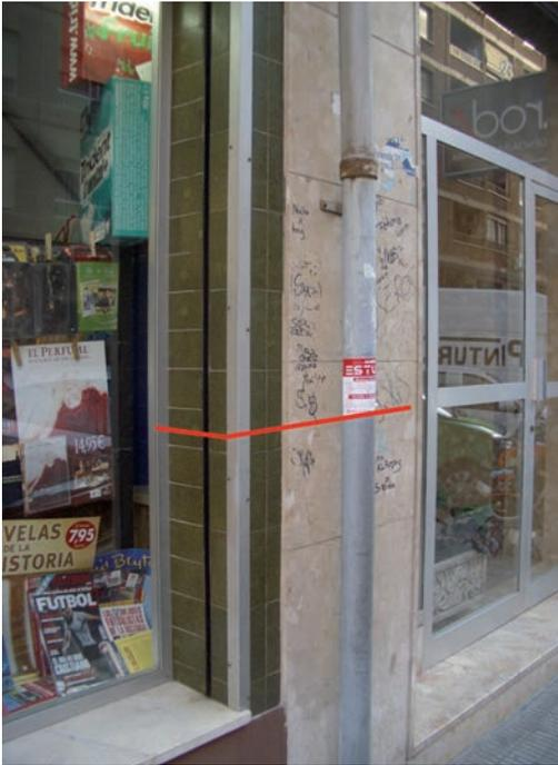
Imagen 25. Detalle de la distancia existente entre las aperturas de local y el zaguán del edificio de viviendas colindante, superándose sobradamente la longitud de 0,50 m, según SI 2, art 1.
