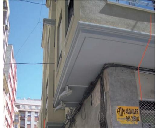
Imagen 18. Detalle de la fachada existente en el local, en la cual se evidencia el voladizo que sirve de compartimentación del local con las viviendas existentes en la planta superior, superándose sobradamente la longitud de 1,00 m, según el punto 3 del art 2 del SI 2.
