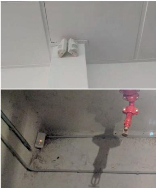
Imagen 42. Detectores de presencia contra robo e intrusión.
