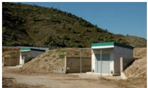
Imagen 26. Almacenes de productos terminados, protegidos por merlones de tierra y muros resistentes.
