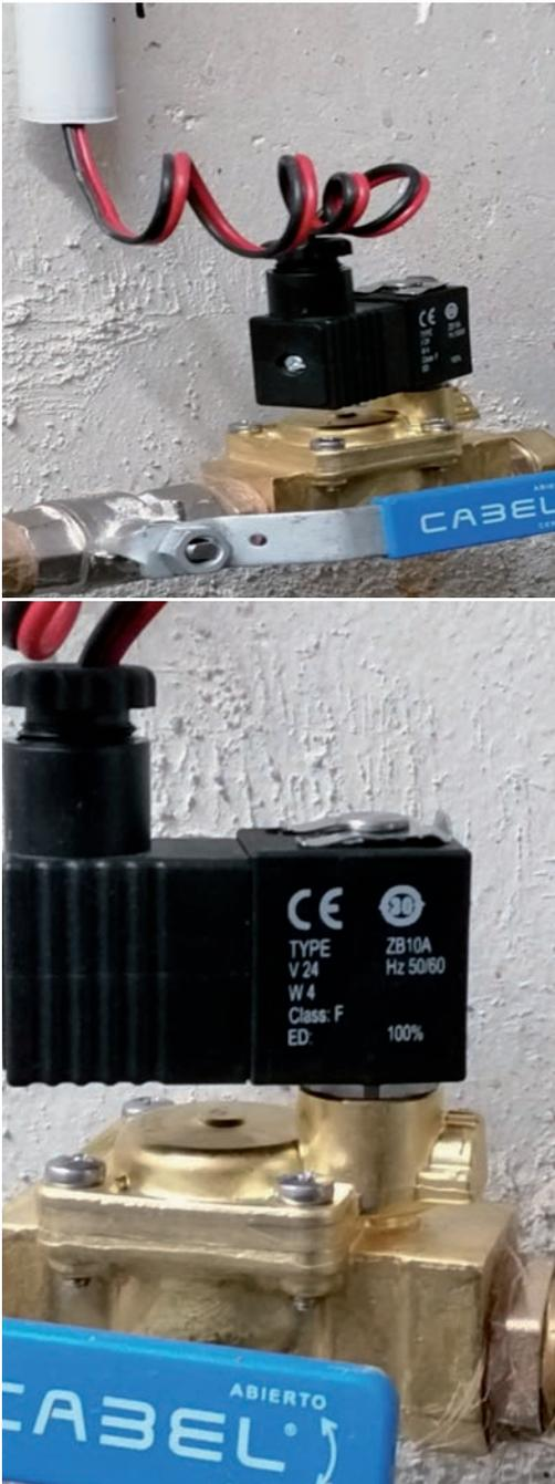
Imagen 33. Detalle válvula automática de accionamiento del sistema de extinción automática, que recibe la señal desde la central de detección.
