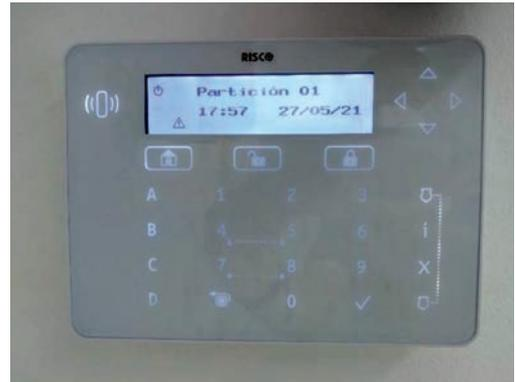
Imagen 45. Central de detección de alarma contra robo e intrusión.
