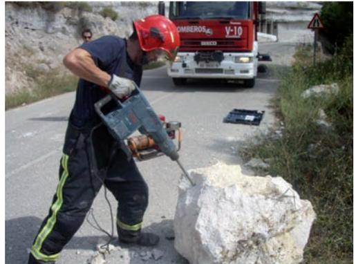
Imagen 11. Utilización en operaciones de taqueo de bolos y material rocoso deteriorado.
