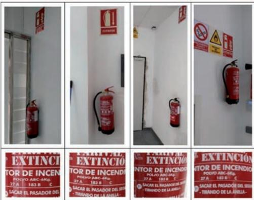
Imagen 38. Extintores instalados y señalización asociado y obligatoria.
