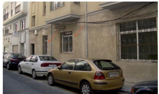
Imagen 19. Detalle de la fachada existente en el local en estudio, en la cual se evidencia el voladizo que sirve de compartimentación del local con las viviendas existentes en la planta superior, superándose sobradamente la longitud de 1,00 m, según el punto 3 del art 2 del SI 2.
