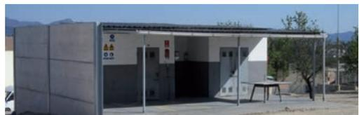
Imagen 22. Casetas de procesos en taller de pirotecnia. Nótese la existencia de elementos de defensa contra explosiones (muro) y la existencia de pararrayos.
