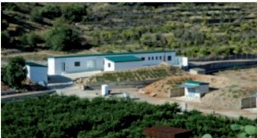
Imagen 47. Ejemplos de merlón de defensa asociado a edificio, en el cual no se cumplen los parámetros de altura de protección.
