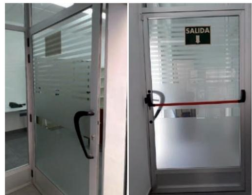
Imagen 29. Detalle puerta de evacuación de local de venta, dotadas de barras antipánico y rápida apertura.
