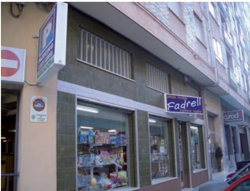
Imagen 26. Detalle de la fachada existente en el local, en la cual se evidencia el voladizo que sirve de compartimentación del local con las viviendas existentes en la planta superior, superándose sobradamente la longitud de 1,00 m, según el punto 3 del art 2 del SI 2.
