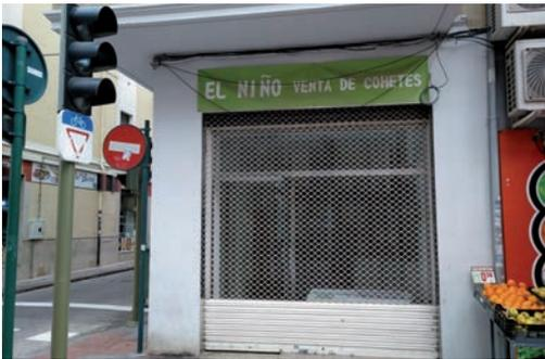
Imagen 16. Detalle de la distancia existente entre las aperturas de local y el local colindante, superándose la longitud de 0,50 m, al formar las fachadas un ángulo de 180°, según SI 2, art 1.
