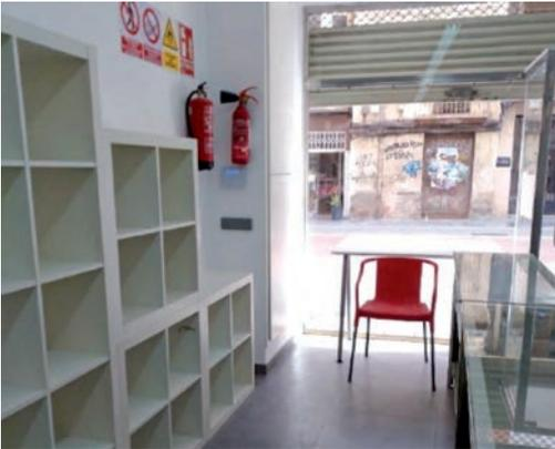
Imagen 37. Detalle extintores de incendios de servicio en establecimiento. Nótese la necesidad de señalar su existencia.
