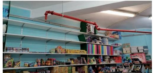
Imagen 34. Detalle sistema automático contra incendios en zona de exposición y venta.
