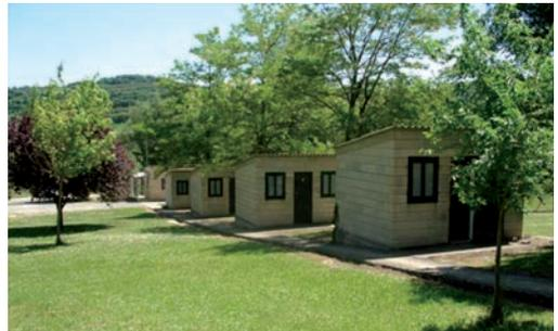
Imagen 25. Casetas de elaboración de taller pirotecnia. Nótese la misma orientación de puertas y ventanas en casetas adyacentes.
