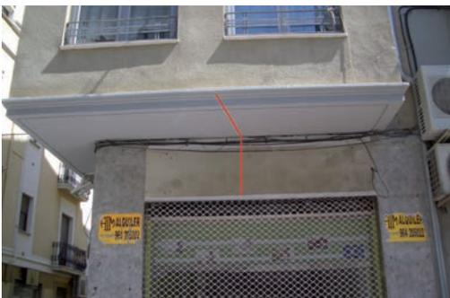
Imagen 17. Detalle de la fachada existente en el local, en la cual se evidencia el voladizo que sirve de compartimentación del local con las viviendas existentes en la planta superior, superándose sobradamente la longitud de 1,00 m, según el punto 3 del art 2 del SI 2.
