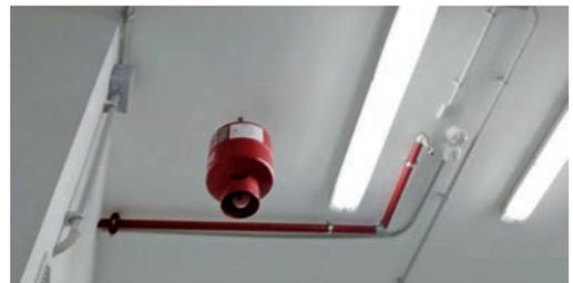
Imagen 35. Detalle sistema alimentación desde red general de suministro al automático contra incendios en establecimiento de venta de artificios pirotécnicos.
