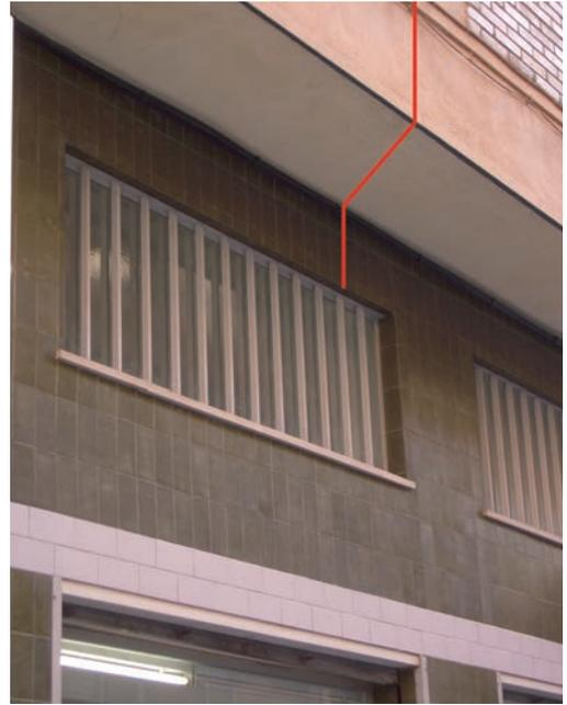
Imagen 27. Detalle de la fachada existente en el local, en la cual se evidencia el voladizo que sirve de compartimentación del local con las viviendas existentes en la planta superior, superándose sobradamente la longitud de 1,00 m, según el punto 3 del art 2 del SI 2.
