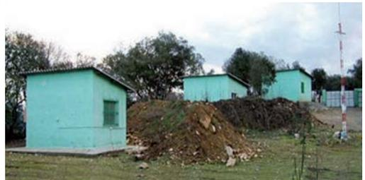
Imagen 48. Merlón de defensa asociado a edificio, en el cual no se cumplen los parámetros de altura de protección.
