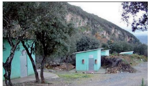
Imagen 28. Detalles de casetas de producción, con defensas tipo merlón asociadas. Véase la no eficacia de las defensas existentes.
