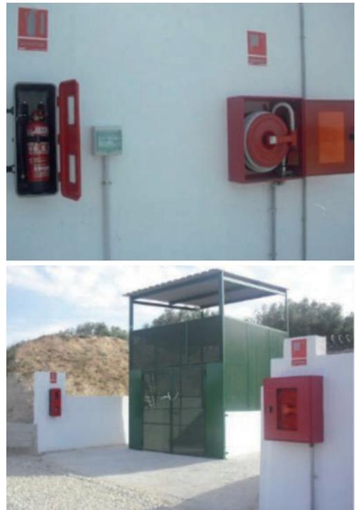
Imagen 65. Dotación de material de lucha contra el fuego en dependencias de Taller de Pirotecnia.
