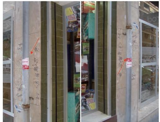
Imagen 28. Detalle de la canalización de PVC, que discurre por la fachada de la actividad. Nótese que dicha canalización sirve de evacuación de aguas pluviales del edificio y no es utilizada como canalización de gas natural ni energía eléctrica.
