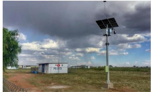
Imagen 68. Detalle báculo dotado de cámaras y sensores de vigilancia, con alimentación fotovoltaica. En este caso las señales se transmiten via radio con protección contra sabotaje.
