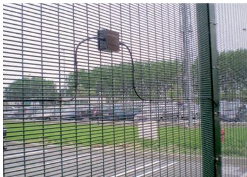
Imagen 67. Detalle vallado de cierre perimetral anti-escalo, dotado de sensores.
