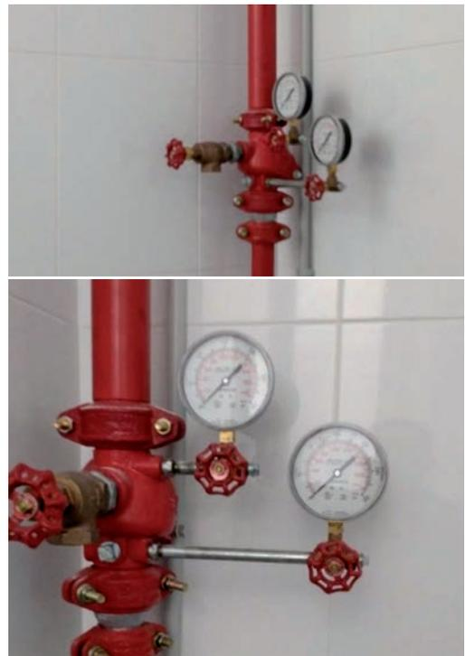
Imagen 32. Detalle del sistema de alimentación y regulación de la red contra incendios de suministro a los rociadores automáticos.
