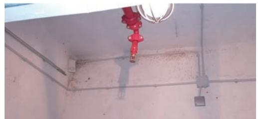
Imagen 36. Detalle sistema automático contra incendios en almacén de productos pirotécnicos.
