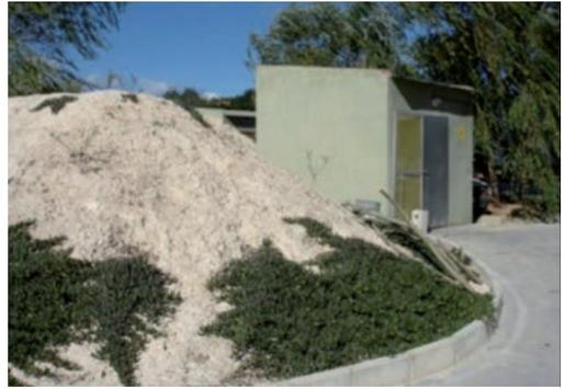
Imagen 47. Merlón de defensa asociado a edificio, en el cual no se cumplen los parámetros de altura de protección.
